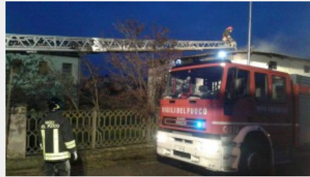
Monti. Incendio distrugge il tetto in eternit di una casa del centro.
